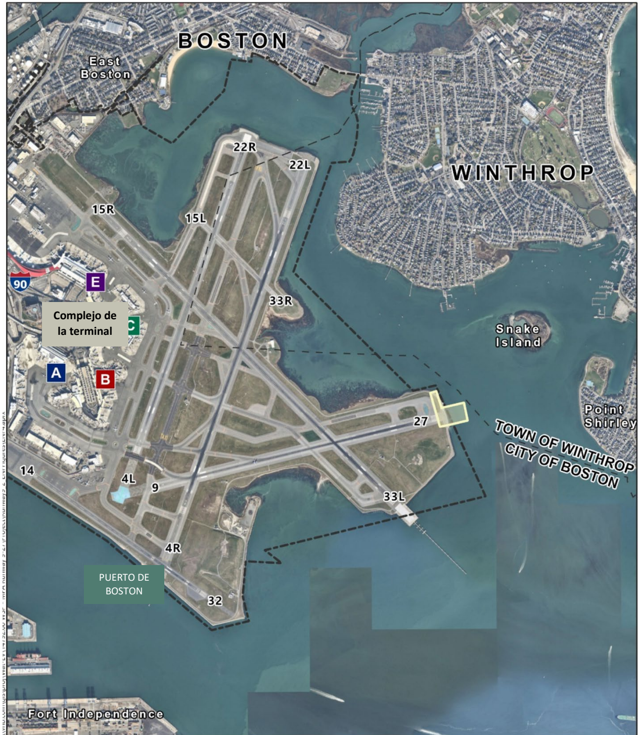
Figura RE-1 Vista aérea del aeropuerto Logan
